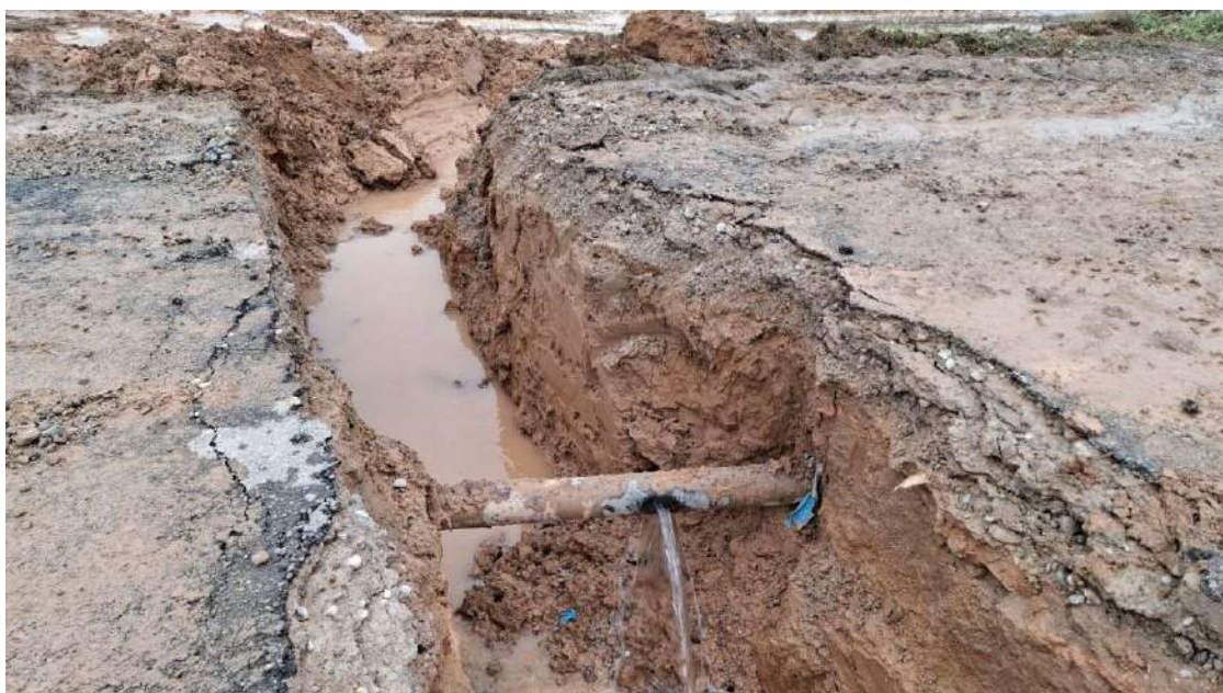
La Asociación de Vecinos Horta Sur denuncia nuevos cortes de agua en Quatre Pilans y Terme de Grealó por las obras de Solaria, que también cortaron la circulación y bloquearon vías.
