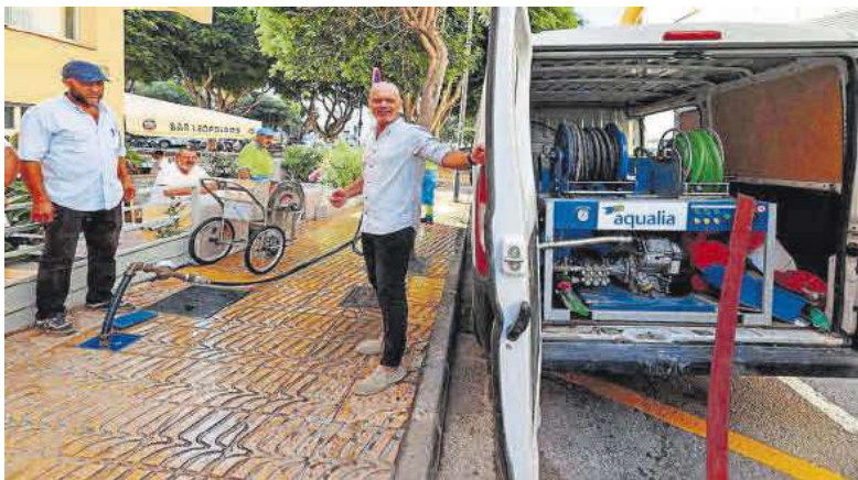
El nuevo punto de carga de agua en la calle Port de la Savina de ses Figueretes. | MARCELO SASTRE
