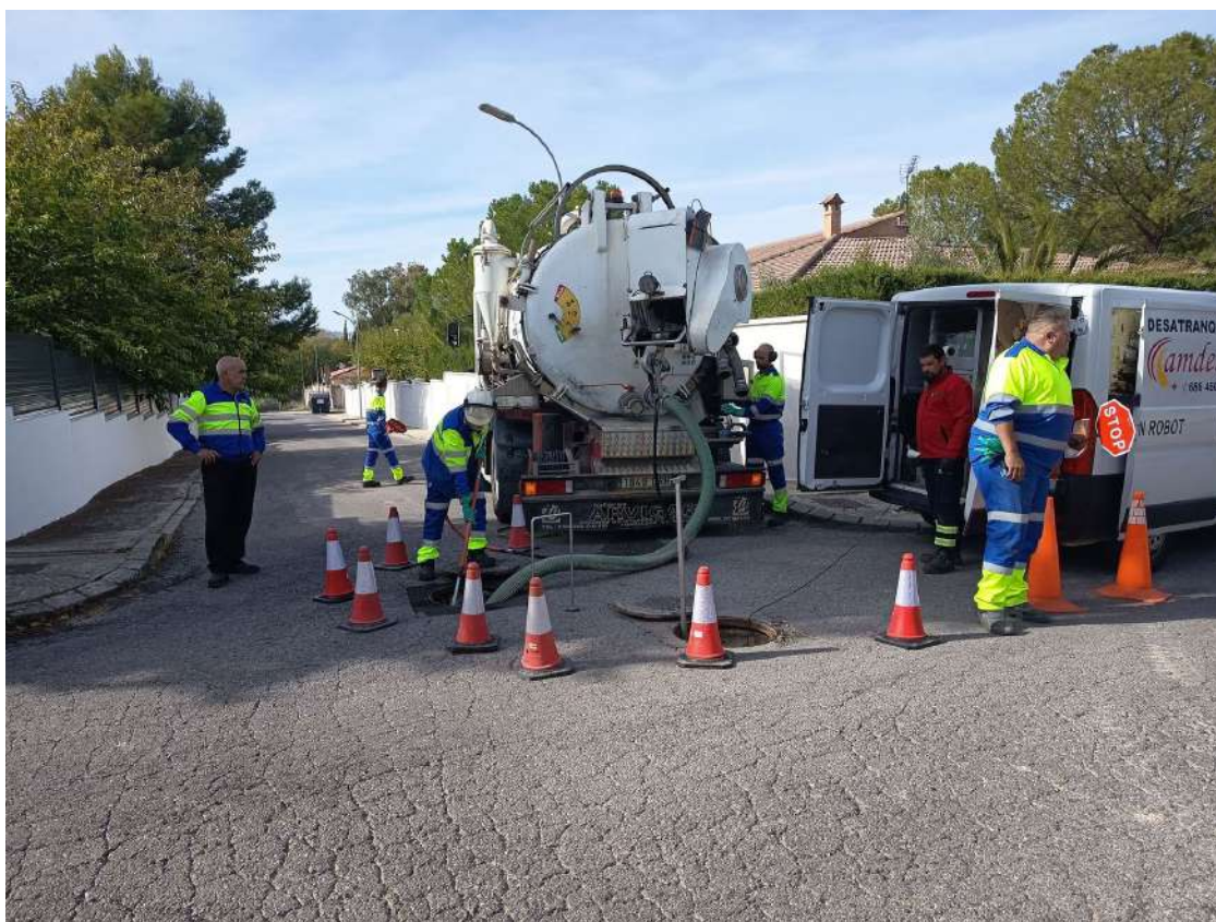
Trabajos de Aqualia en la red de saneamiento del Puente Tablas.
