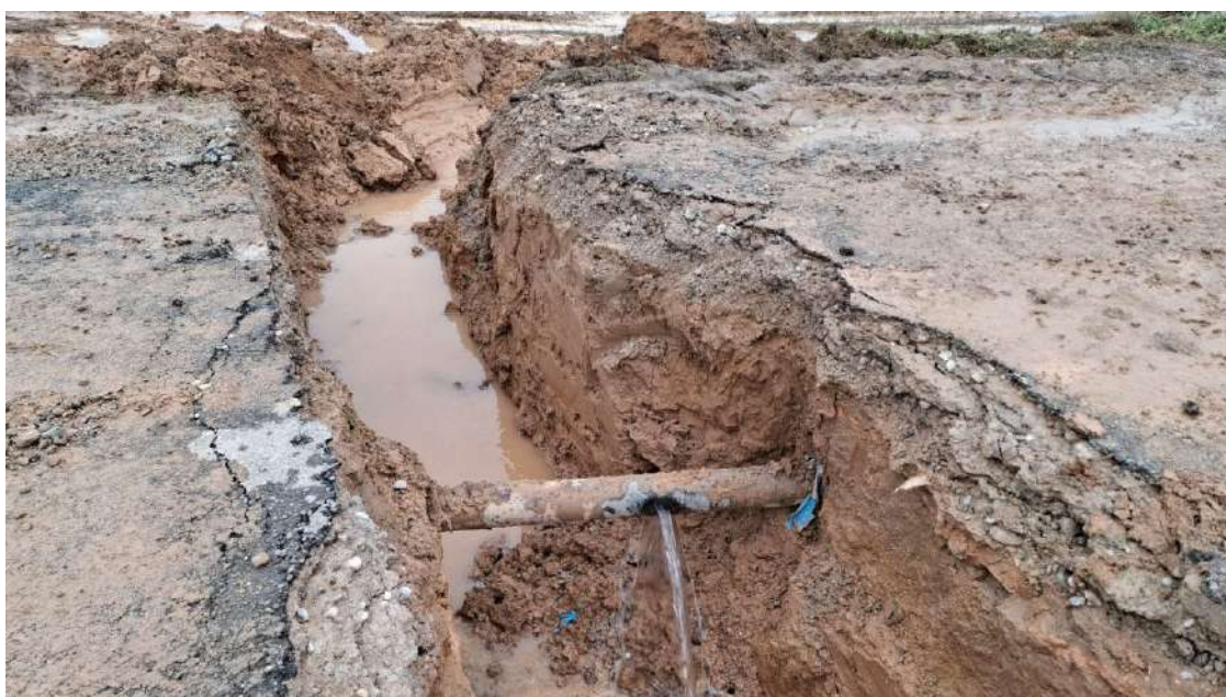
L'Associació de Veïns Horta Sud denuncia nous talls d'aigua a Quatre Pilans i Terme de Grealó per les obres de Solaria, que també van tallar la circulació i van bloquejar vies.
