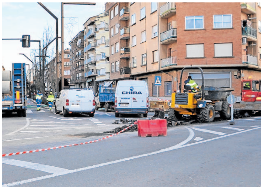
Ayer continuaban los trabajos de reparación del colector entre Numancia y Achútegui de Blas. I. Á.
