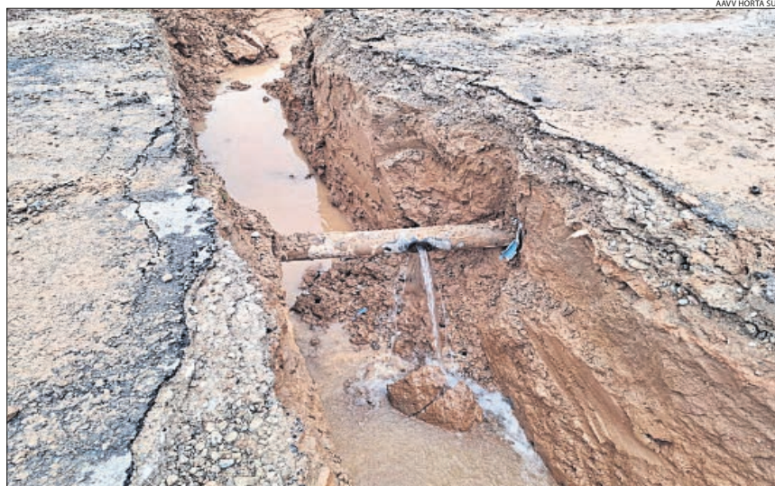
El reventón forzó el corte de la tubería general hacia Quatre Pilans y Grealó durante la reparación.
